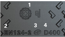
1 - Identification du fabricant 2 - Norme de référence 3 - Marque de l’organisme de certification 4 - Classe de résistance
