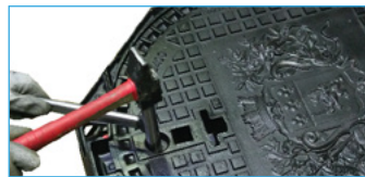
2 Défoncer la pastille avec un outil de surface plane Ø 20 mm maxi de type emporte pièce
