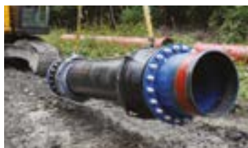
Raccord Géoflex en cours d'installation sur la conduite forcée de la centrale hydro électrique des Encombres, en Savoie
